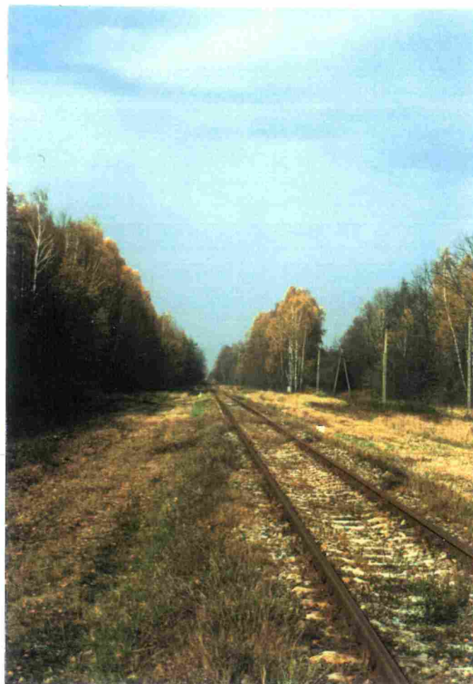
JEDNOTOROWA LINIA KOLEJOWA RELACJI SIEDLCE-MAŁKINIA
