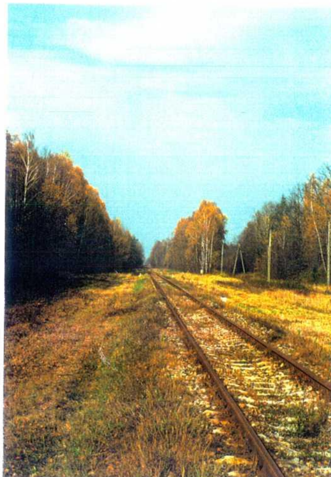
JEDNOTOROWA LINIA KOLEJOWA RELACJI SIEDLCE-MAŁKINIA
