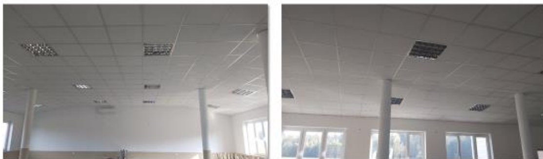
Wykonany sufit w świetlicy w Walerowie
