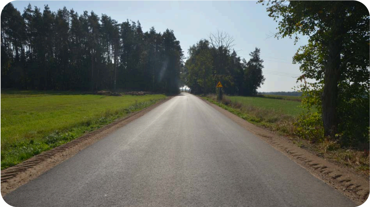
Przebudowa drogi gminnej na odcinku Brzozów - Czerwonka
