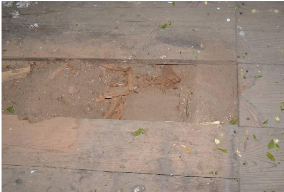
Porażony przez grzyby domowe legar pod bocznym byłym zachodnim ołtarzem bocznym
