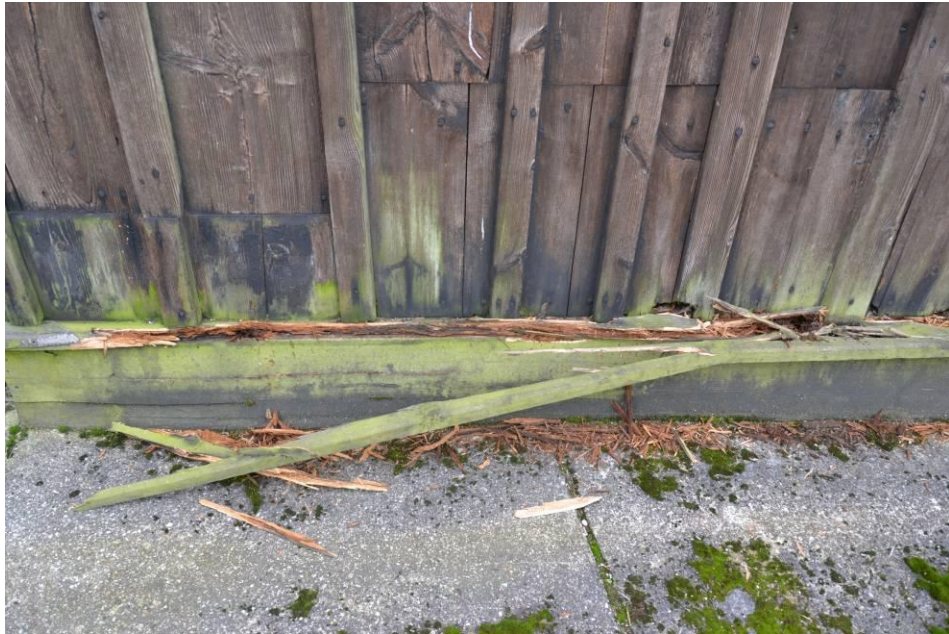
Porażone przez grzyby i owady deski osłonowe podwaliny oraz deski okapowe od strony północnej
