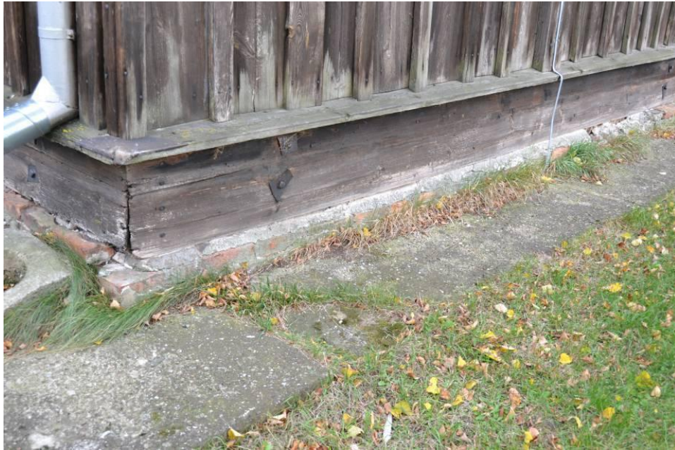
Podmurówka narożnika południowo-wschodniego bryły głównej.
