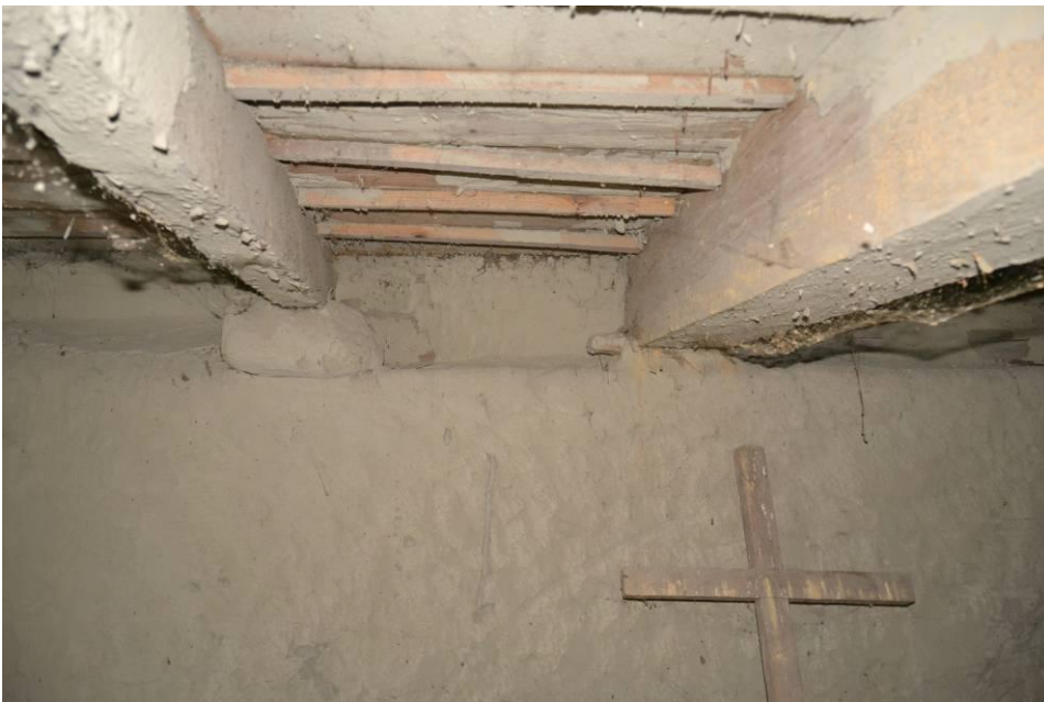
Nowe belki stropowe o małych przekrojach podparte kamieniem na ścianie fundamentowej oraz listwami drewnianymi.
