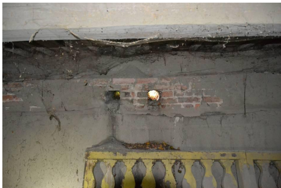
Ściana fundamentowa podpiwniczenia pod prezbiterium strona południowa – widoczne dwa kanały wentylacyjne.
