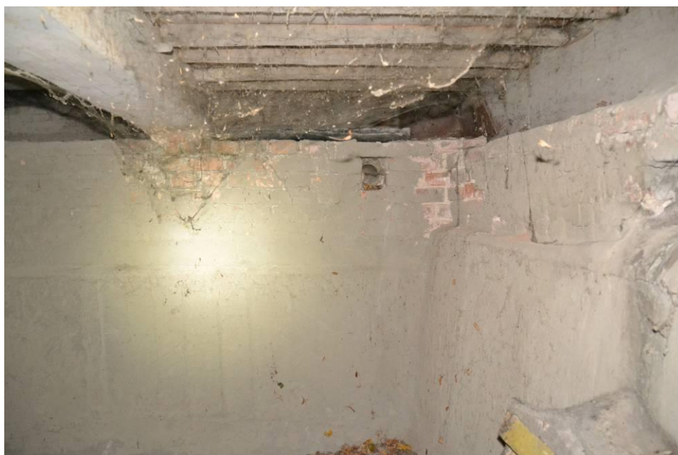
Ściany fundamentowe podpiwniczenia pod prezbiterium – naroże południowo-wschodnie.
